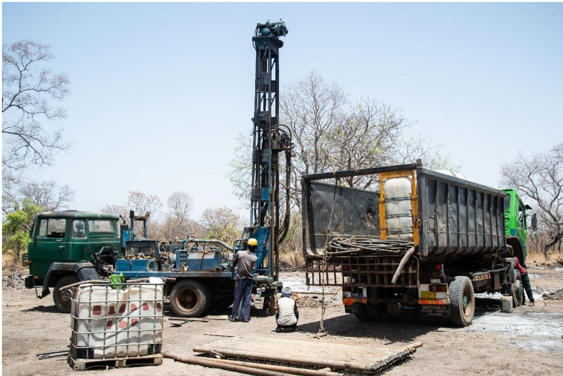
Balligho. Das zweite Bohrloch wird gebohrt
